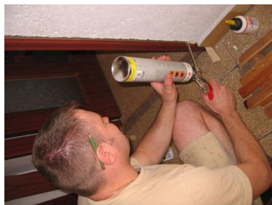
Ha a beállítás megtörtént, rögzítjük az utólag beépíthető ajtótokot PUR habbal. Azért hogy a hab, ne nyomja be a tokot, a padló vonalában és kb. 1 m magasan az ajtónyílásba tegyünk távtartót.
